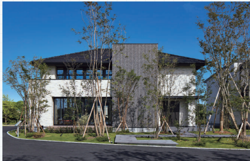
「Ai-COSS」を導入することで、タイルを下地サイディングに張り付けたアイ工務店オリジナルの一体型パネル「TOWA」を購入することも可能
